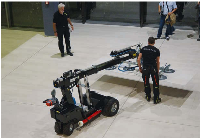
3. Arbeitsschritt: Verlegen der Platten mit Verlegerobotern • 3rd work step: Installing the panels with robots
