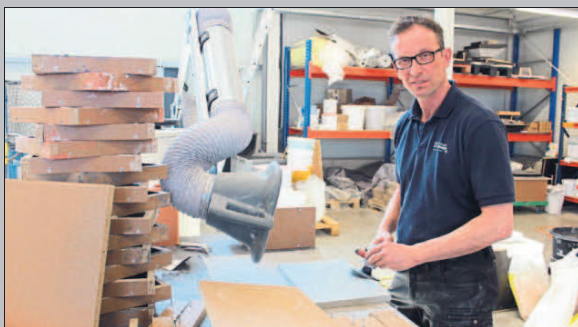
Thomas Berlin schleift für die Kottmeyer-Tochter STIL.2018 ein Betonelement.
